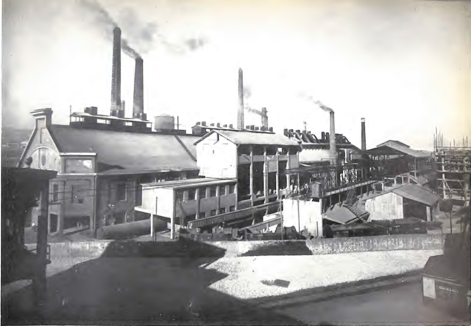
Vado Ligure - Deposito minerali e fabbricati per la preparazione delle cariche e per i forni.
